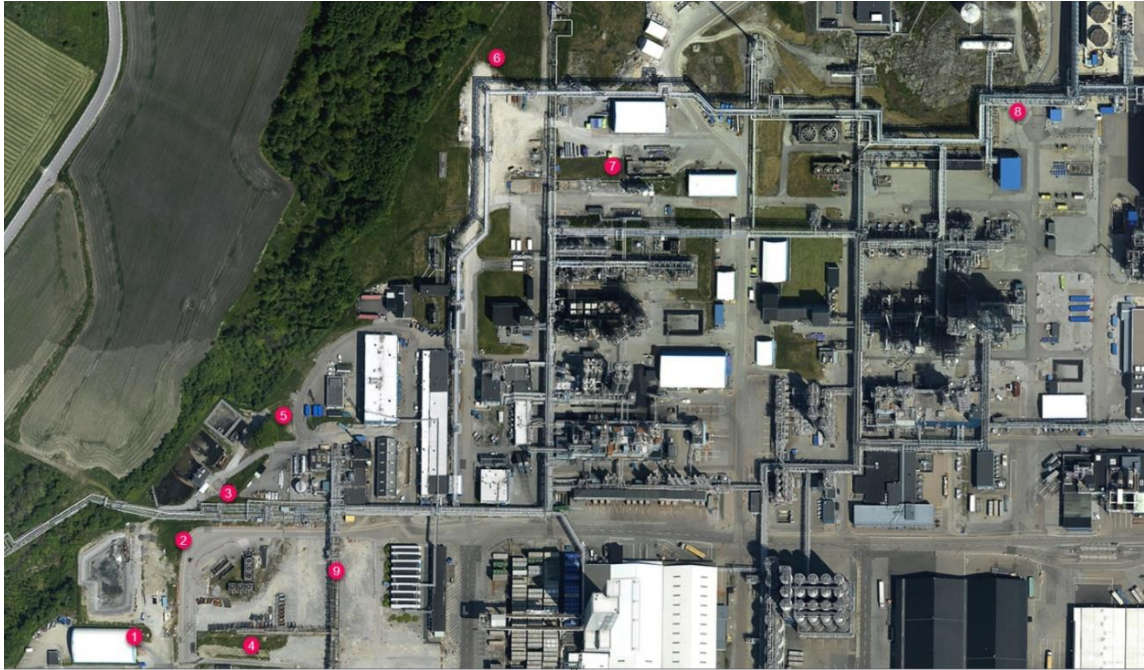
Figur 3 Grundvattenrör för kontroll av eventuella föroreningar vid tre tillfällen per år.
