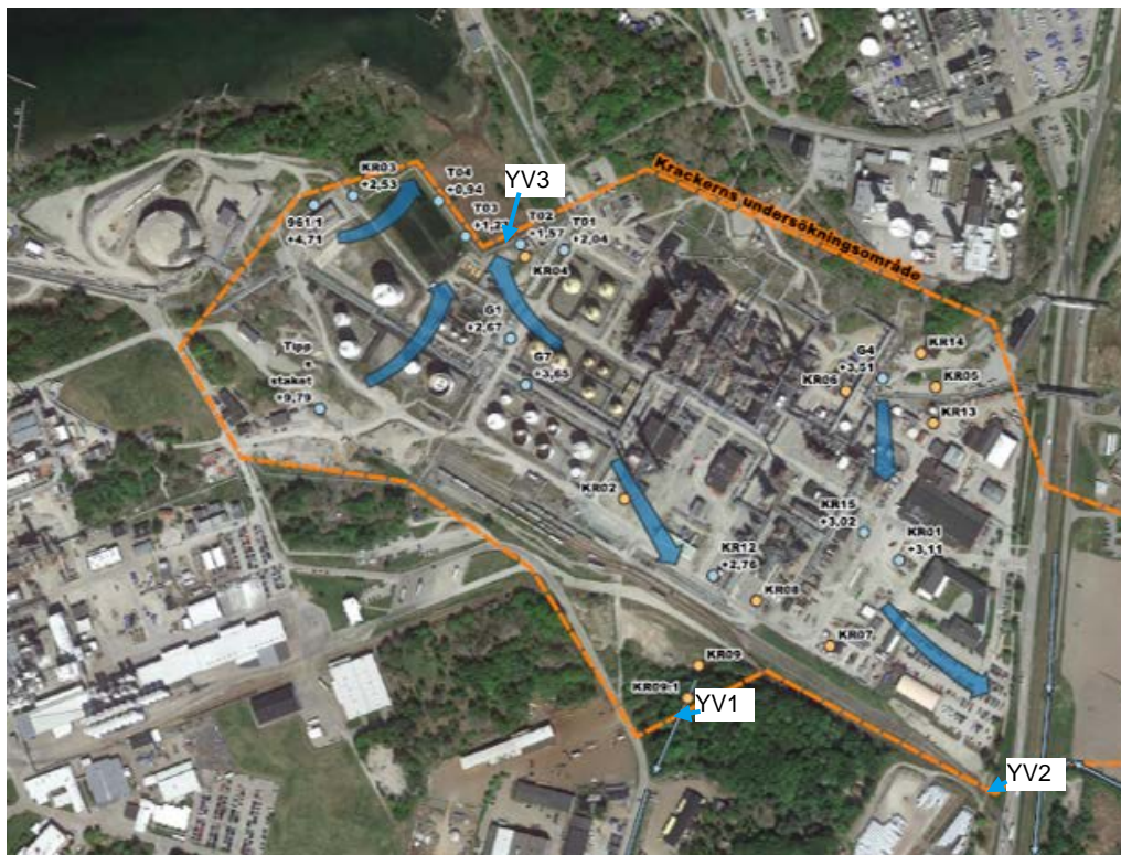
Figur 7 Grundvattenrörens och ytvattenpunkteras placering. Blå pilar visar grundvattnets flödes riktning.
