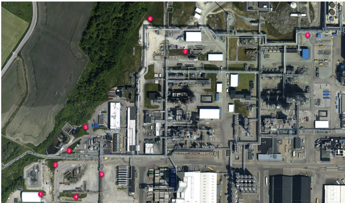
Figur 4 Grundvattenrör för kontroll av eventuella föroreningar vid tre tillfällen per år.
