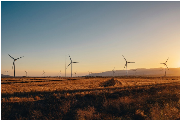
Foto: Borealis unterzeichnete zwei langfristige Stromabnahmeverträge mit Ilmatar Energy, um den Anteil erneuerbarer Energie für den Betrieb seiner Anlagen in Finnland deutlich zu erhöhen.
