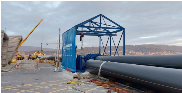
Foto | Die extrem hohe Widerstandsfähigkeit gegen langsames Risswachstum („Slow Crack Growth“, SCG) von BorSafe HE3490-SLS-H ermöglicht kürzere Installationszeiten und eine höhere Kosteneffizienz. Foto: © Politejo
